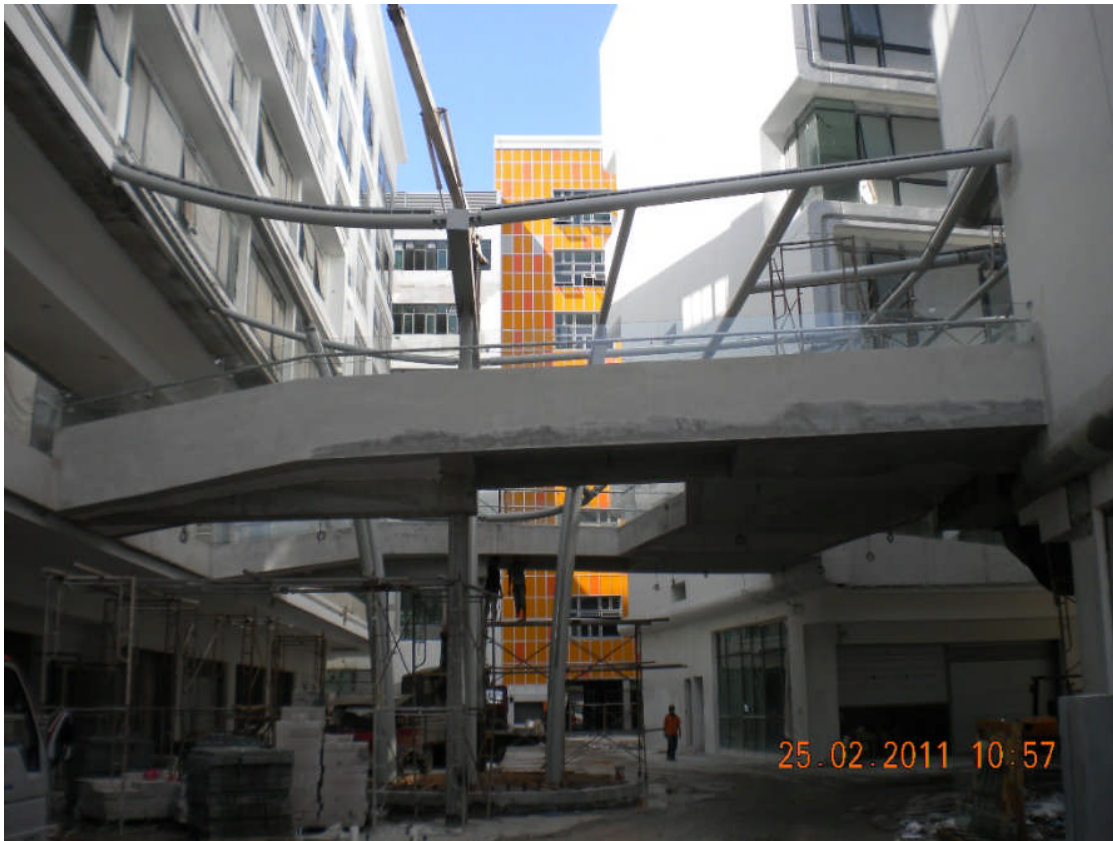
Block B, C & D - Escalator Tensile Fabric Canopy
